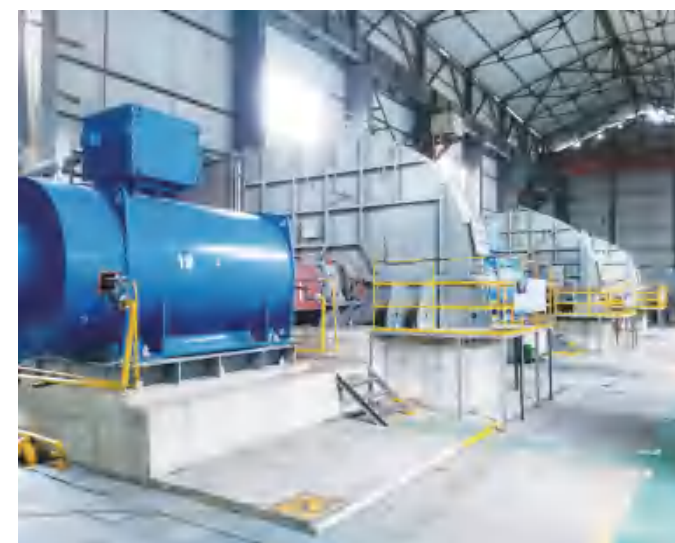
◆ 高义钢铁OG风机 Gaoyi Steel OG Fan Retrofit
